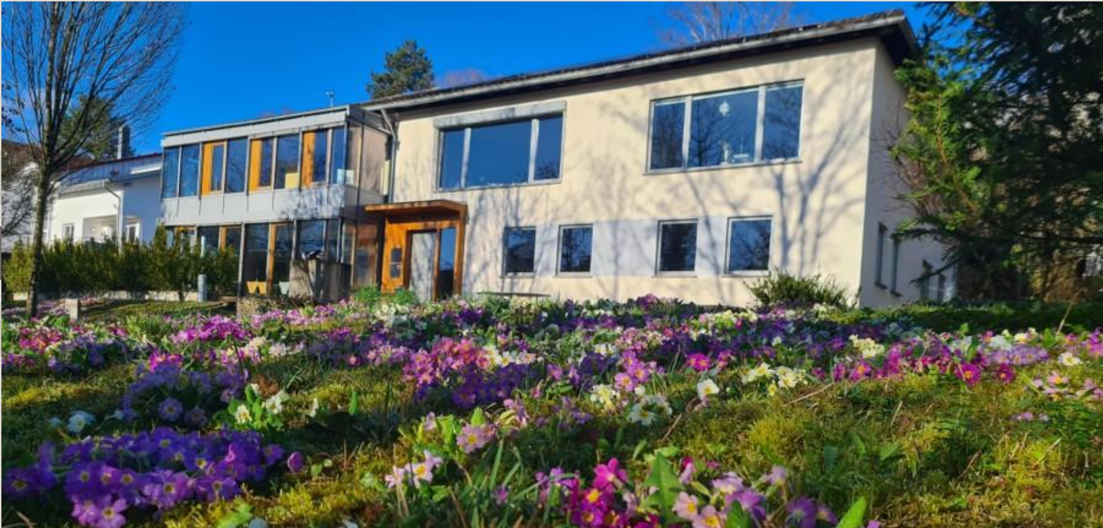
GEORG-ZUNDEL-HAUS DER BERGHOF FOUNDATION IN TÜBINGEN
